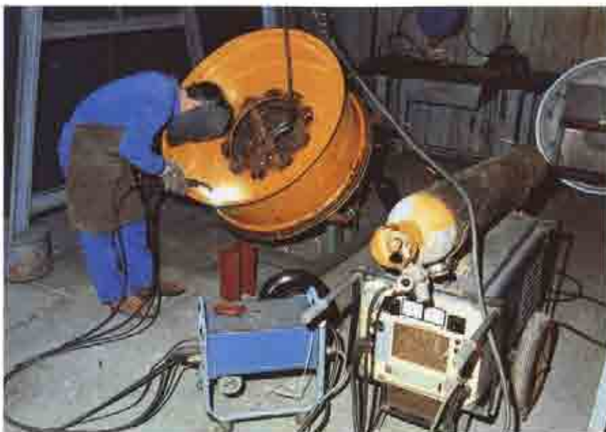
Soporte para soldadura en llantas - (antes).
