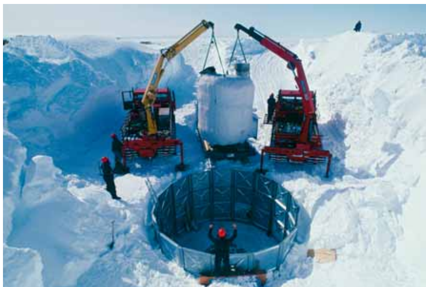
El primer paso a realizar tras estabilizar y nivelar una grúa móvil autopropulsada será el de designar, si las condiciones de visibilidad lo requieren, a un encargado de señales.
