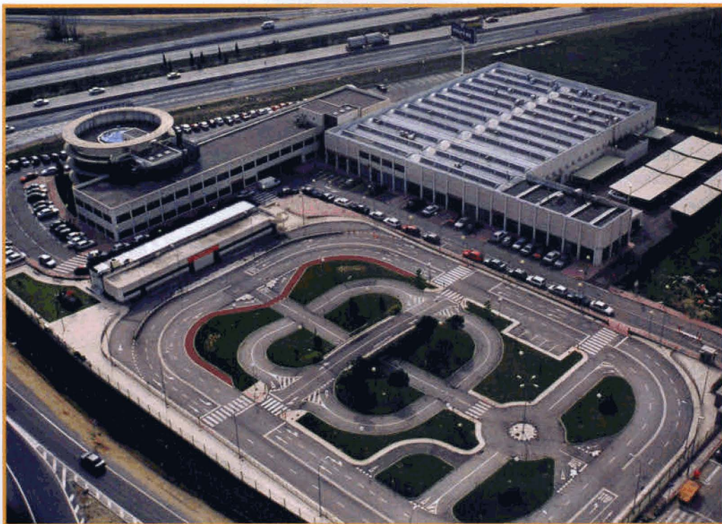
Panorámica aérea de las instalaciones del Instituto MAPFRE de Seguridad Vial en Alcalá de Henares.
