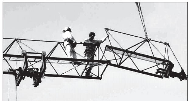
Figura 21. Montadores sujetos con EPI a la estructura
