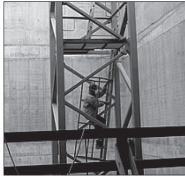
Figura 17. Escala de acceso protegida
