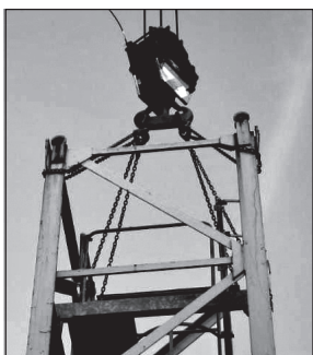
Figura 7. Eslingado correcto de componentes alargados
