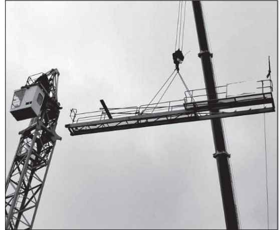
Figura 14. Guiado de la carga
