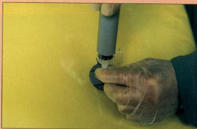
Foto 8. Colocación del inyector.
