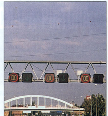
Panel luminoso informativo de señalización.
