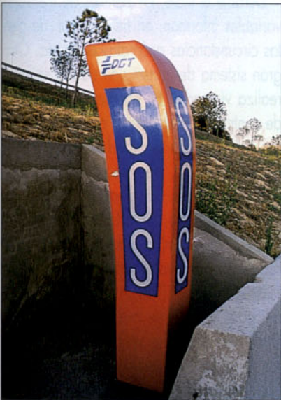
Poste telefónico de comunicación de incidentes (SOS).
