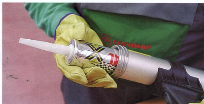
contaminación existentes. Para ello, se realiza una limpieza de la zona de la luna en la que se va a producir el pegado, mediante el limpiador de vidrio Betaclean 3300.
