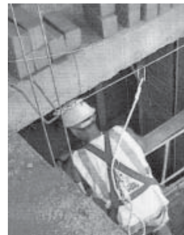
11. Un trabajador de Hunosa, en el momento de la construcción de un puente. 12. Un trabajador de Hunosa, en el momento de la construcción de un puente. 13. Un trabajador de Hunosa, en el momento de la construcción de un puente.
