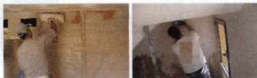
Figura 103 - Yevista: trabajo en paredes.
