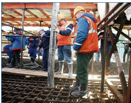
Trabajadores en la construcción de la unidad 2 de Leningrad
