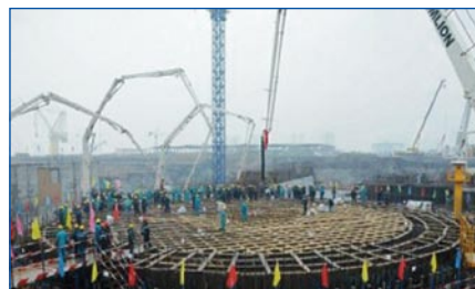
Construcción de la central de Changjiang
