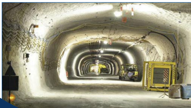
Vista de la marcha de los trabajos a 840 metros
