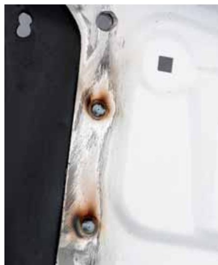
► Puntos de soldadura
