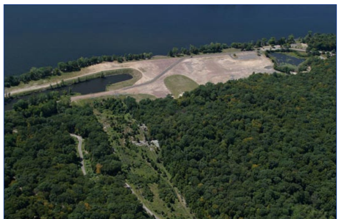
Vista actual del emplazamiento de la antigua central nuclear Connecticut Yankee (© Connecticut Yankee).
