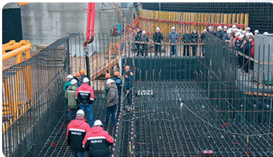
Hormigonado de losa en Ostrovets-1 (© Belarus AEC).
