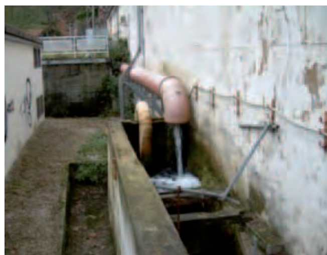
Figura 73. Canal de vertido general Pozo Barredo (10-07-2007)
