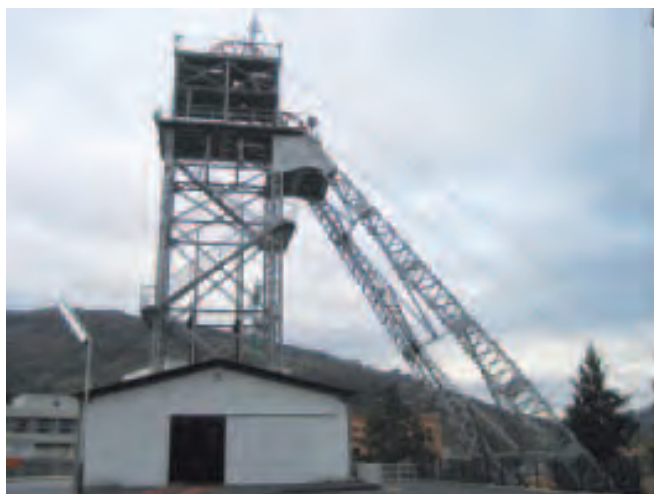
Figura 14. Vista del Pozo Barredo
