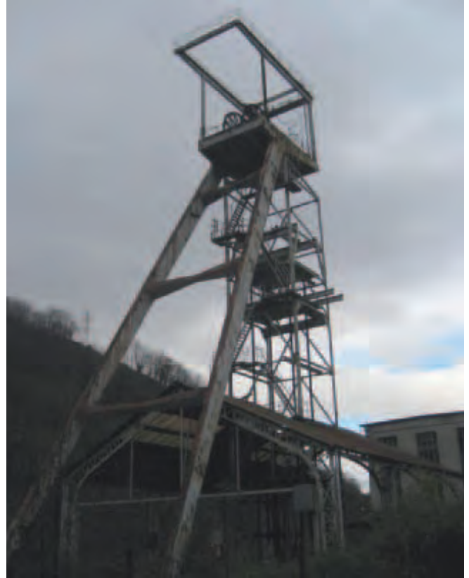
Figura 21. Vista del Pozo Santa Bárbara
