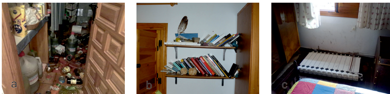
Figura 2. Durante el terremoto de Lorca de 2011 se identificaron los elementos peligrosos más característicos en una vivienda. Por ejemplo: a.- no tener armarios cerrados con pestillo, b.- elementos de estanterías que pueden caer sobre camas o sofás, y c.- elementos que por su peso pueden caer sobre personas y provocar graves heridas.
