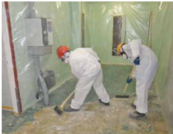
Figura 5. Ejemplo de medidas preventivas en un trabajo de retirada de losetas de amianto vinilo: barreras críticas, trabajo en húmedo, herramientas manuales, ropa de trabajo, equipo de protección respiratoria, retirada continua de residuos.
