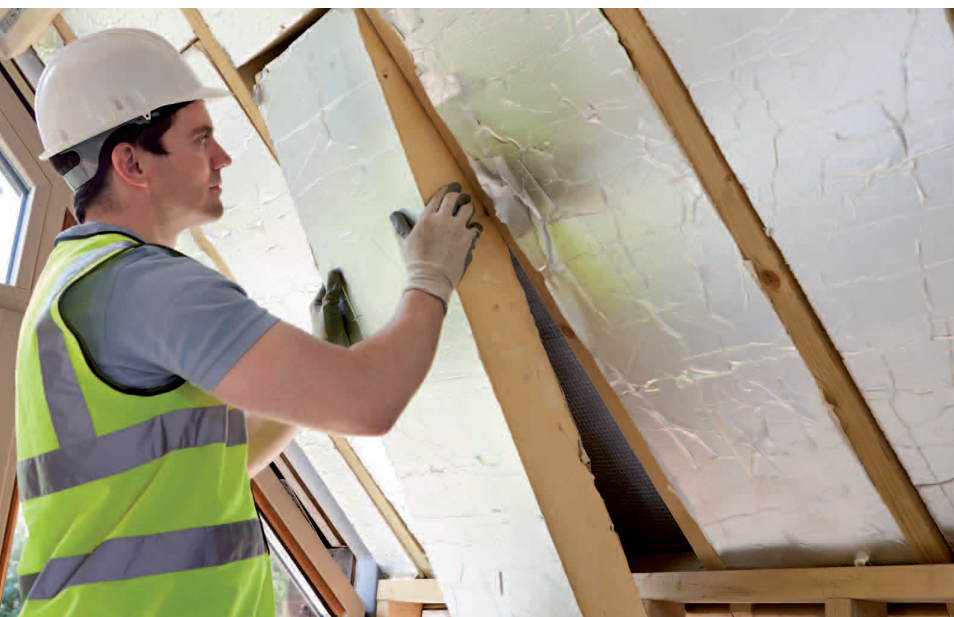
Trabajador realizando tareas de aislamiento
