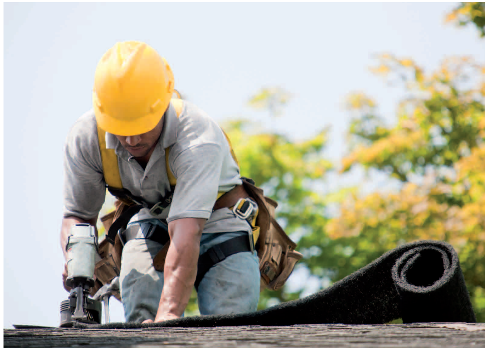
Trabajador realizando trabajos de impermeabilización
