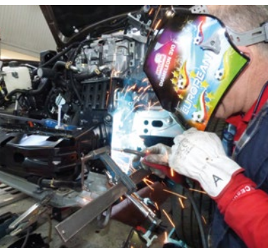
► Reparación del frente delantero y de la parte trasera del Mitsubishi Outlander PHEV
