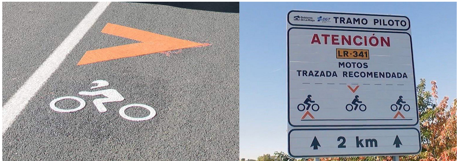
Figura 115. Prueba piloto de cartelería y marcas viales para la mejora del trazado de las motos en las curvas.
