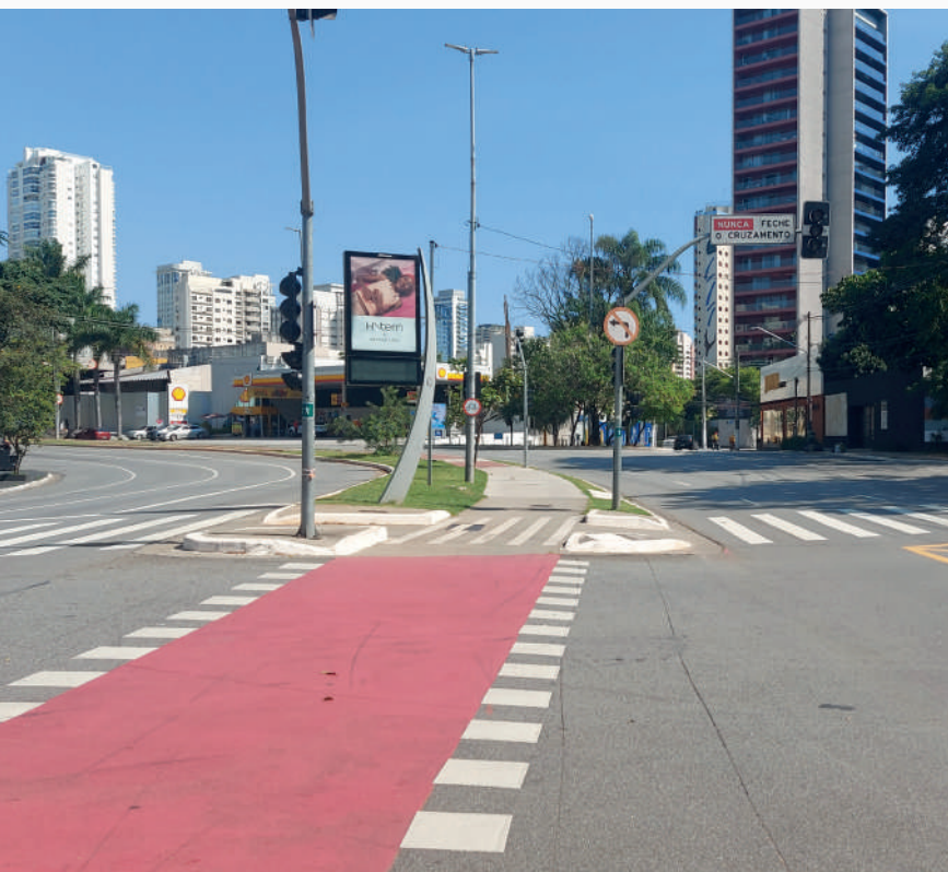
Figura 65 - Trecho da ciclovia da Rua Michel Milan, em São Paulo (SP).
