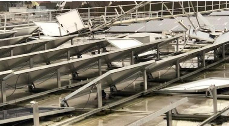
*Levante por viento de módulos fotovoltaicos en cubierta*
