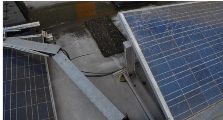
*Rotura de módulos fotovoltaicos y cableado*
