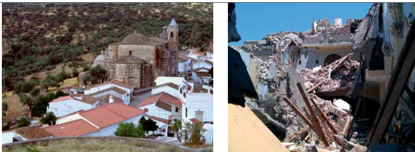
Iglesia de San Juan (izquierda) y ruinas del convento de las Clarisas, en Lorca. Ambos edificios registraron diferentes daños a causa del terremoto.
