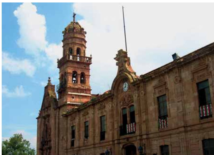
El convento de San Diego, en Morelia, presenta una fachada reconstruida mediante sillares engatillados a raíz del terremoto de 1858.
