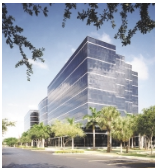
Edificio de las oficinas de MAPFRE ASISTENCIA en Estados Unidos.
