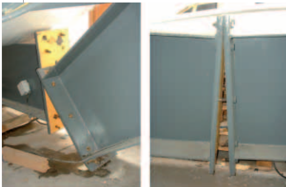
Detalle de la estructura siniestrada y de dos de los tornillos de unión entre las piezas que componían los pórticos.
