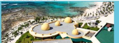
Detalle de cubiertas de la fase III de Maya
