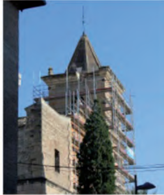
Figura 18. Daños estructurales en remates singulares
